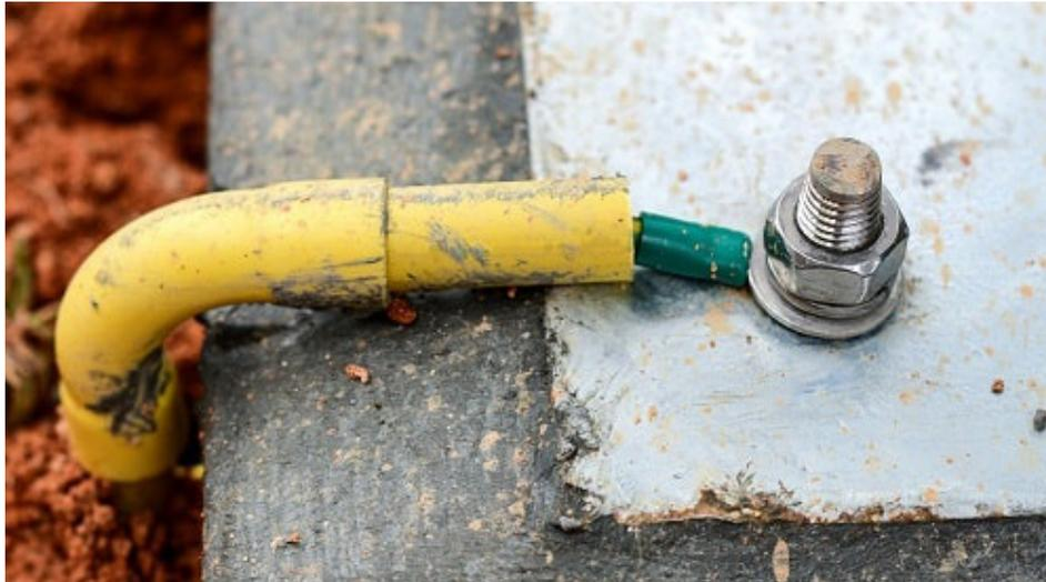
Obligatoire et essentielle, c'est un élément qui assure la sécurité d'une installation électrique. En effet, elle protège les personnes en cas de défaut d'isolement d'un appareil électrique.
